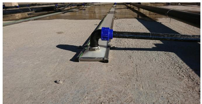
Beim Umbau des Homogenisierungstanks wurde Wert auf ein robustes und energieeffizientes Belüftungssystem gelegt. Die Wahl der Betreiber fiel deshalb auf die feinblasigen AEROSTRIP® Streifenbelüfter.
