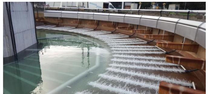
AEROSTRIP® ist dank verschiedener Belüfterlängen und flexibler Einbaumöglichkeiten das optimale Belüftungssystem für dieses innovative Verfahren, welches übrigens auch die komplette Umwälzung ausschließlich mit Druckluftenergie bewältigt.
