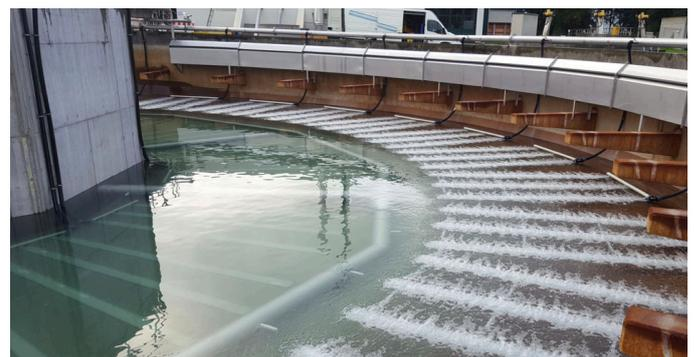
AEROSTRIP® ist dank verschiedener Belüfterlängen und flexibler Einbaumöglichkeiten das optimale Belüftungssystem für dieses innovative Verfahren. Dank dieser feinblasigen Belüfter wird hier übrigens auch die komplette Umwälzung ausschließlich durch Druckluftenergie bewältigt.
